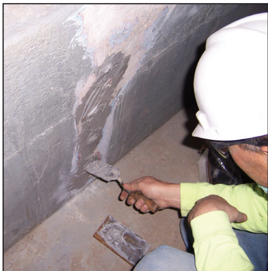
Tratamiento de las grietas con ChemLine® Caulk.
