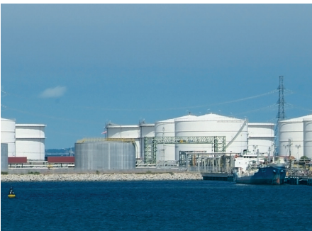
TANQUES DE ALMACENAMIENTO Y TERMINALES.
